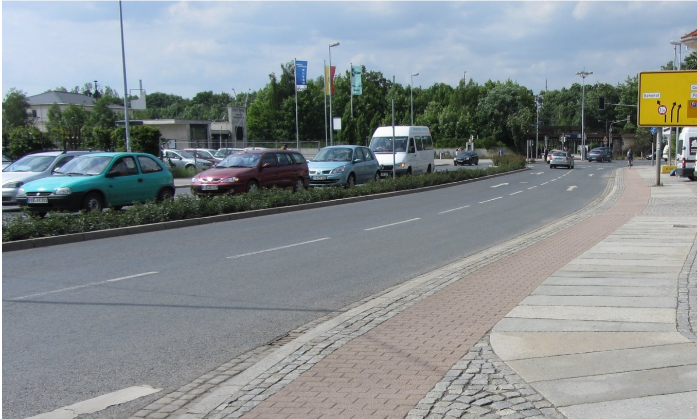
Nördlicher Abschnitt, Blickrichtung Norden
