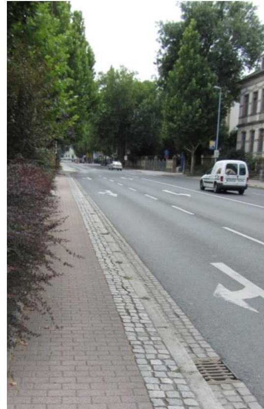
Mittlerer Abschnitt, Blickrichtung Süden
